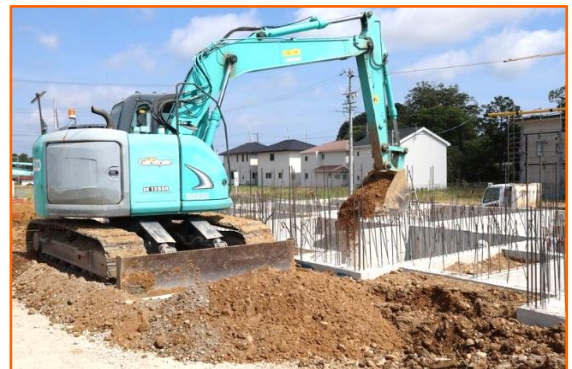
【写真】現在の現場の様子(取材日：8月9日) 基礎工事(埋め戻しの作業)を行っていました。
