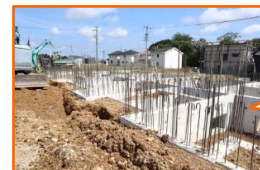
【写真】現在の現場の様子(取材日：8月9日) 基礎工事(埋め戻しの作業)を行っていました。
