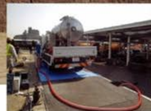
管内注入状況
