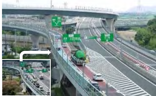
高速道路におけるピンポイント対策 (圏央道 海老名JCTの例)
