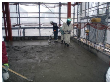
タンピング施工状況
