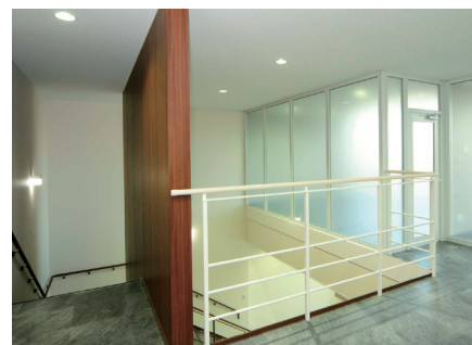
採光間仕切を採用
