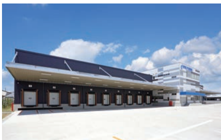
【外観】4色の外壁パネルをランダムに貼ったモダンなデザインが印象的。三温度帯(冷凍、冷蔵、ドライ)での一括管理が可能な高性能倉庫です。
